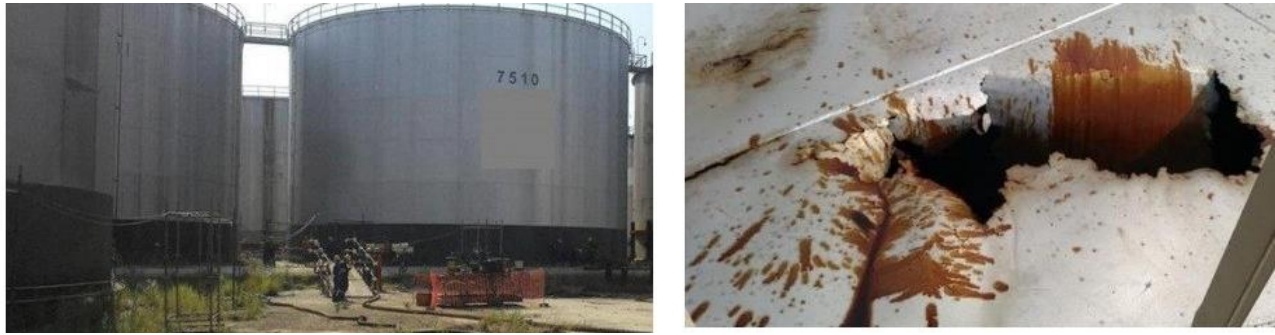
Gambar 6.4 Tangki Minyak Fluida Pemanas dan lubang di atas tangki minyak fluida pemanas
