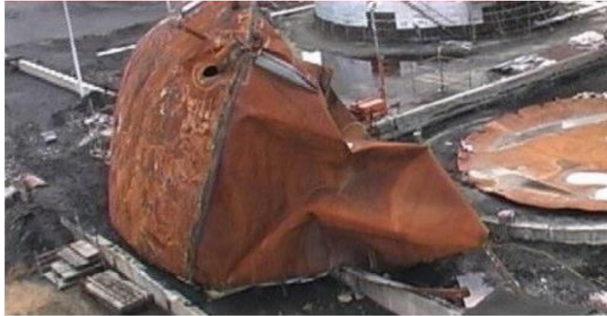
Gambar 6.3 Tangki asam sulfat setelah ledakan
