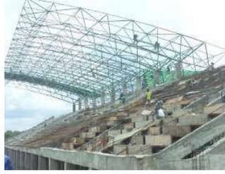
**Gambar 3.14** Sistem joint pada atap tribun
